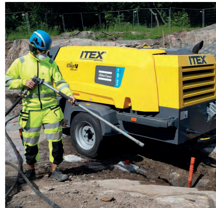
Renblåsning av ett berg som är täckt av jord och gräs, för att kunna borra inför en sprängning.
